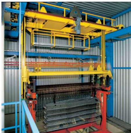
Fot. 3. W stacji przekazywania: elementy metalowe wędrują z przenośnika Power&Free do automatów załadowniczych
